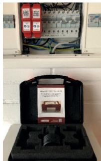
RCD-Prüfadapter im Unterverteiler zur Schleifenimpedanz-messung
